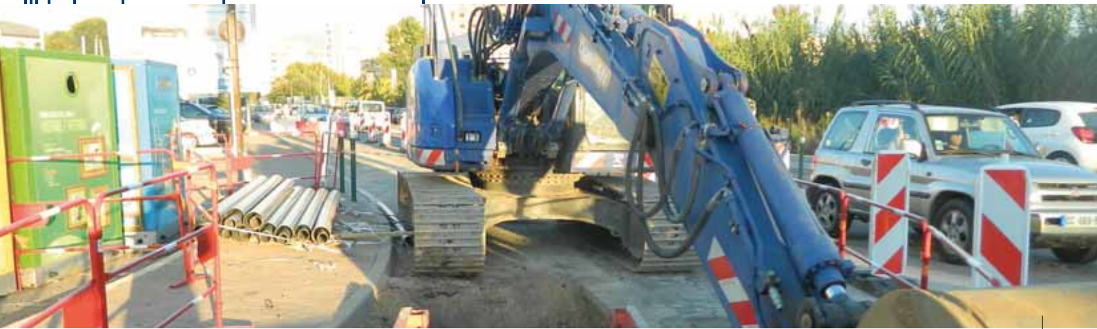
Trafic dense autour du chantier en centre-ville
