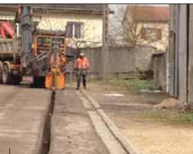
Un exemple de tranchée en Haute Marne.
